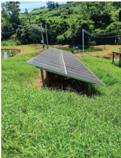
Figura 4.13: UFV sem cerca, identificação e vegetação sem manutenção.
