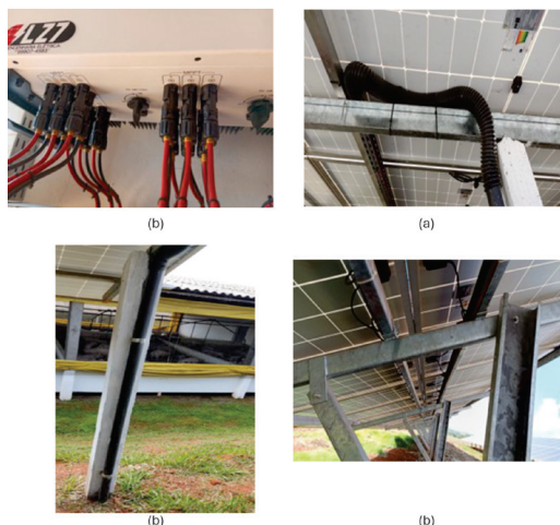
Figura 4.9: Elementos em boas condições de um UFV (a) conectores e condutores; (b) eletrodutos.
