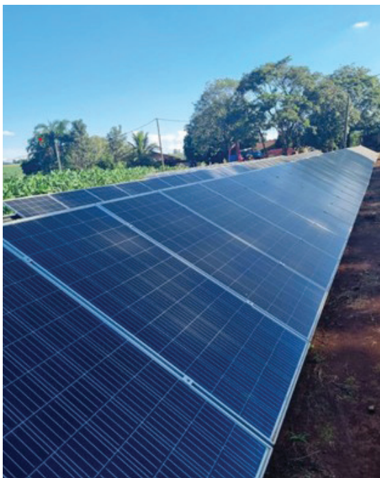
Figura 5.5: Sistema fotovoltaico próximo a uma fonte de Sombreamento
