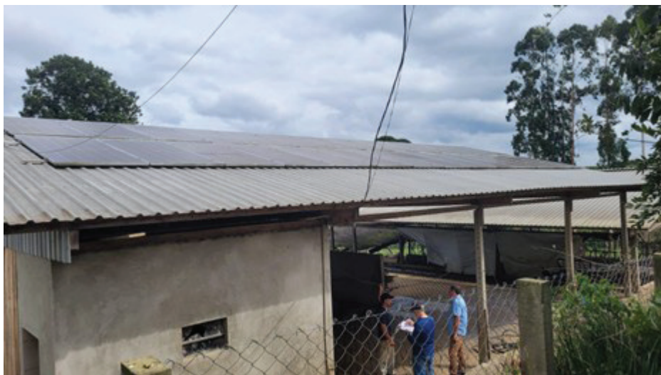
Figura 5.3: Sistema fotovoltaico instalado em telhado.
