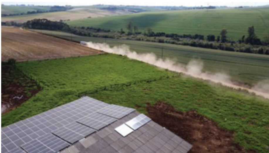
Figura 5.4: Sistema fotovoltaico próximo a uma fonte de sujeidade.
