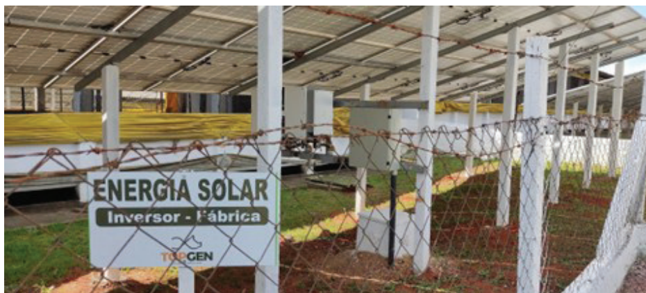
Figura 4.12: UFV cercada e identificada para impedir o acesso indevido.
