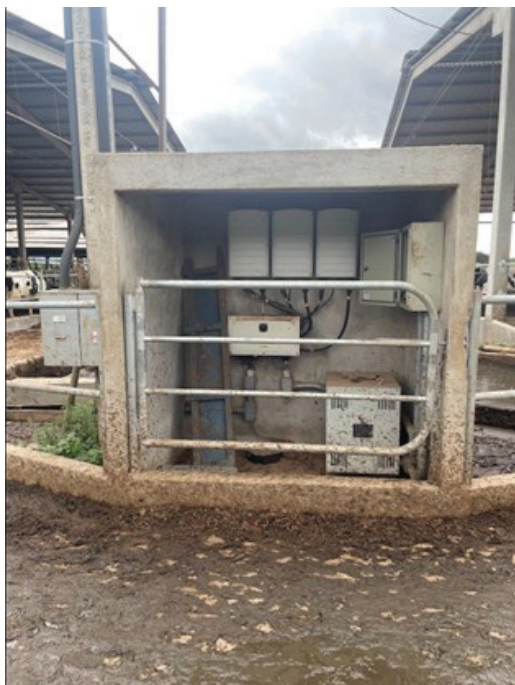
Figura 5.7: Inversor exposto à sujeira e à umidade
