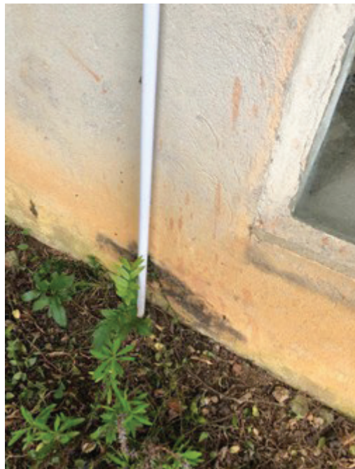
Figura 5.6: Aterramento irregular do Sistema Fotovoltaico
